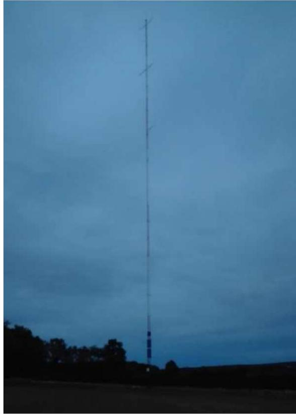
*Figure 5 : Photo du mât de mesure de Dissangis, d'une hauteur de 100m*
